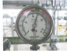
รูปมาตรวัดแรงดันที่ติดตั้งหลังจากอุปกรณ์รับลดแรงดัน
